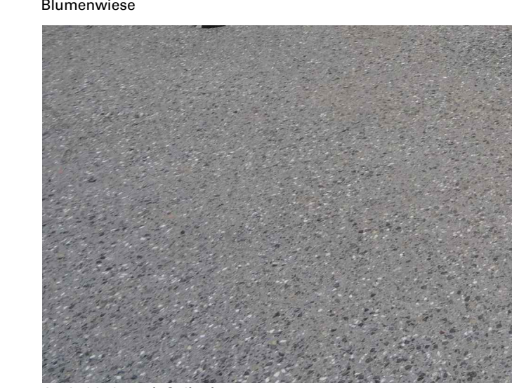
Asphaltbelag mit Splittestreue
